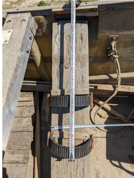
③操船足場転倒落下防止ストラップ
